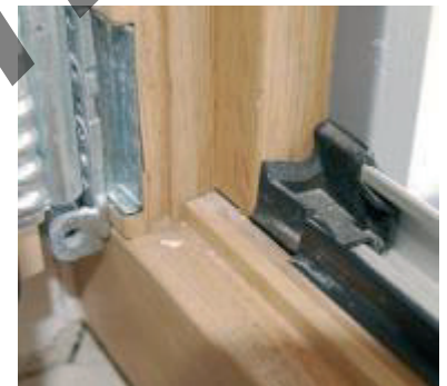
Bild 8.10: Nicht versatzfrei montierte und nicht abgedichtete Endkappe verursachen Luftdurchgang und Wassereintritt
